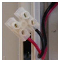
Рисунок 10. Клеммы для подключения замка к блоку питания
