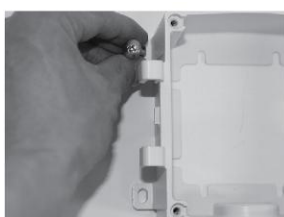
Прикрутите базу саморезами снаружи или, по желанию, изнутри
