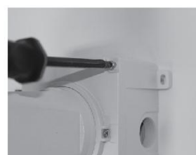
Закрутите винты коммутационной коробки
