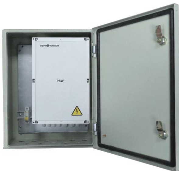
Рисунок 7.3 - Монтаж коммутатора в уличном шкафу.
