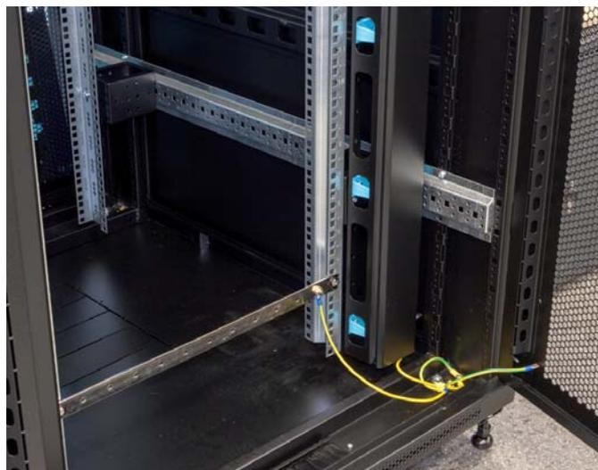
При необходимости, помимо простейшей сборки заземляющего контура (на основе только лишь заземляющих проводов), заземление можно организовать с использованием 19” заземляющей шины или нескольких шин других размеров. Заземляющие шины заказываются отдельно.
