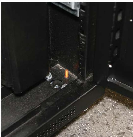
Металлические элементы шкафа, такие как каркас, крыша и основание – оснащены узлами заземления в виде резьбовых шпилек.
